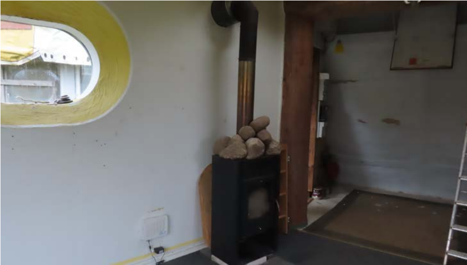
Varmekilden i bygningen er brændeovn
